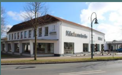
In 2014 renoviert: Möbelhaus Schlötelburg
