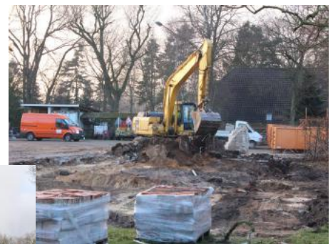
Abriss: Das alte baufällige Baubetriebshofgebäude
