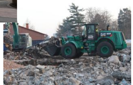
Der Neubau des Netto-Marktes hat begonnen.
