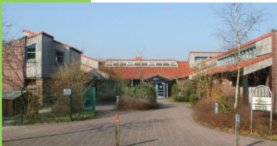
Kindergarten Röbeler Straße
