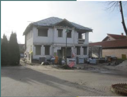
Neubau im Großen Schwerinweg
